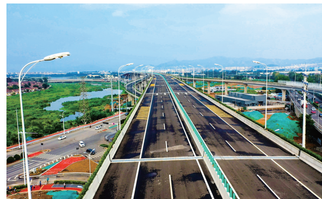
新机场高速连接线(双埠-夏庄段)航拍图。
