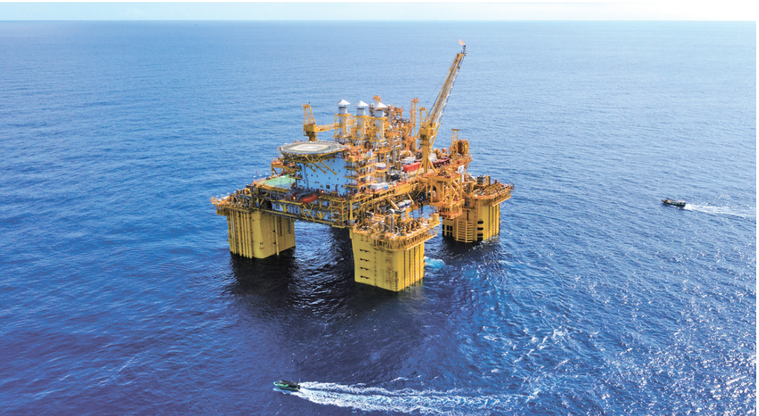
“深海一号”能源站是世界首座十万吨级深水半潜式生产储油平台。
