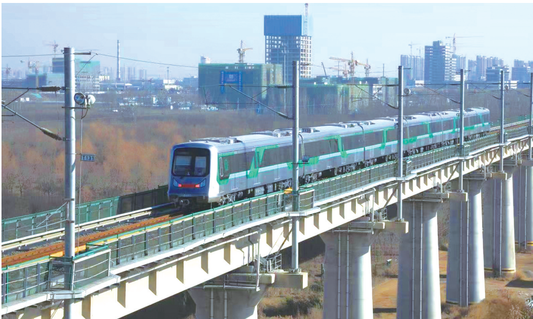
正在试运行中的青岛地铁4号线列车。
