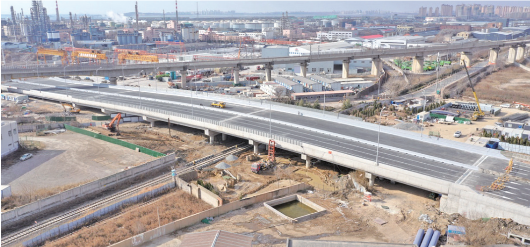
唐河路-安顺路是青岛市东岸城区第五条贯通南北串联三区的快速交通轴线。
