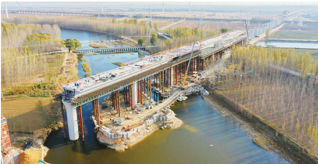
潍烟铁路桥梁桩基全部完成。
