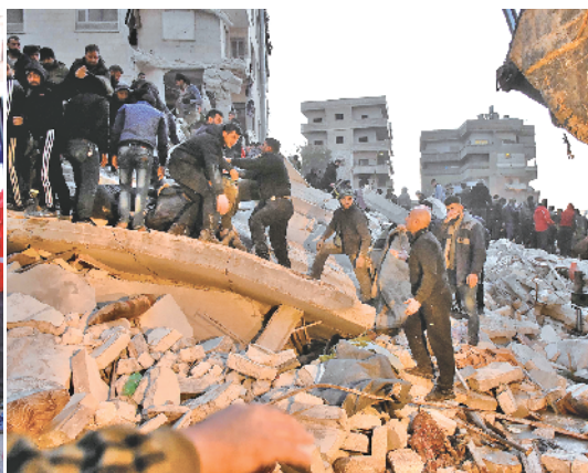
2月6日,人们在叙利亚哈马省一处倒塌的建筑上进行救援。新华社发
