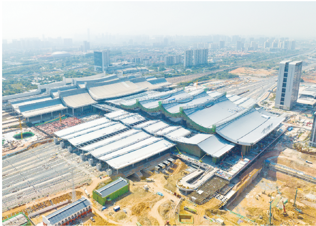
2月23日拍摄的新建福厦铁路厦门北站外景(无人机照片)。新华社发
