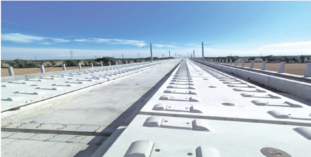
淮烟铁路轨道。
