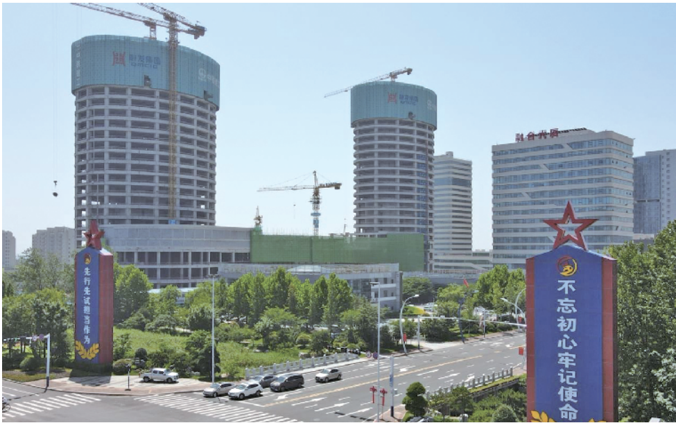
建设中的融发大厦。
