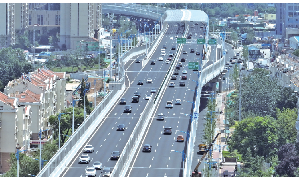
辽阳路快速路(福州路-海尔路段)实现了桥隧相连、东西快速通达。
