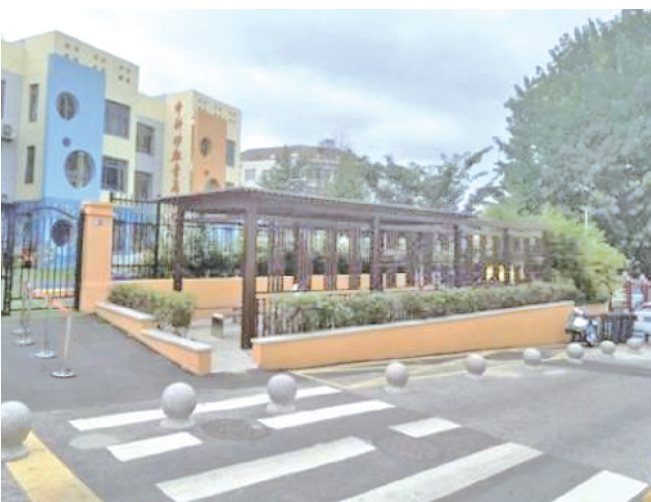
中科幼儿园门口区域“微更新”后建起了等候亭。
