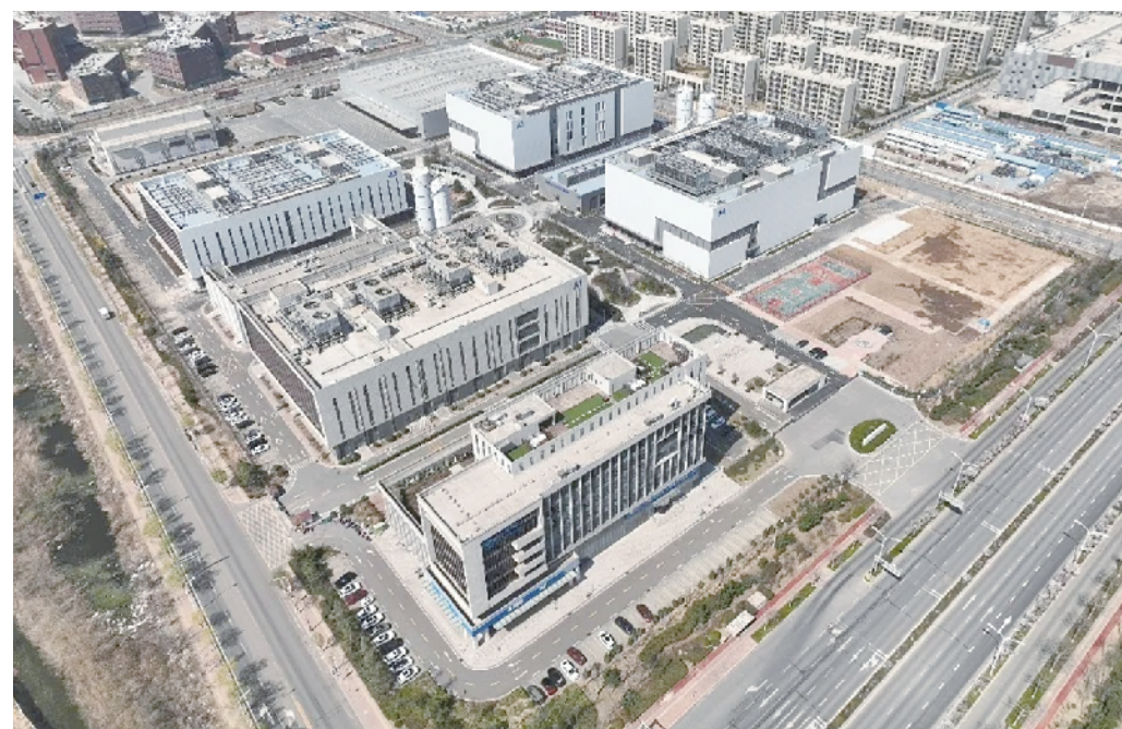
中国移动(山东青岛)数据中心
