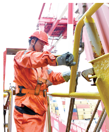
在山东港口青岛港集装箱码头,工人正在进行船舶加固作业。
