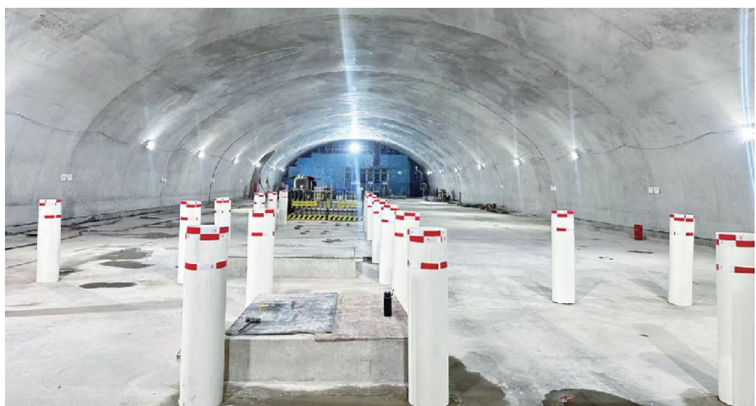
青岛地铁5号线延安二路站施工现场。
